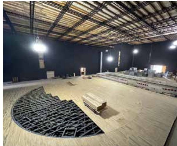
Das helle Holz oben ist eine eingezogene Zwischen- decke, damit gleichzeitig der Bühnenboden verlegt und oben weitergearbeitet werden konnte
